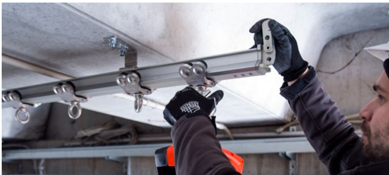
RailSafe su struttura in c.a. installato con staffe Tipo 1 piegate.
