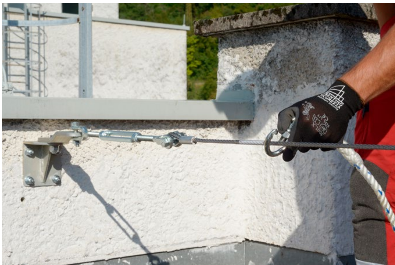
TsSafe con piastra a muro su struttura in c.a.
