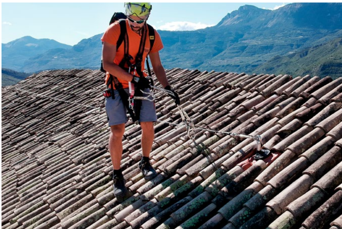
EcoSafe con kit per falda su copertura monofalda in coppi.
