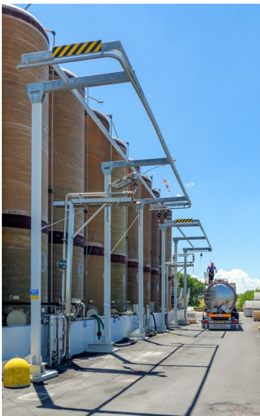
Truck Solution con parte superiore modulabile a sbalzo.
