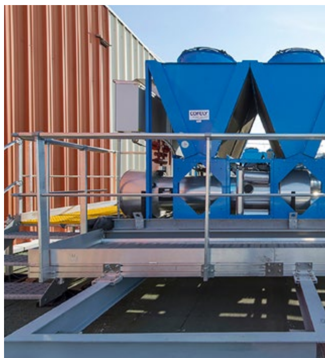
Parapetto dritto fissaggio a muro.
