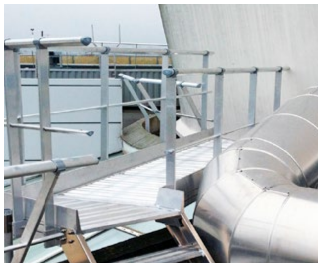
Passerella su misura.
