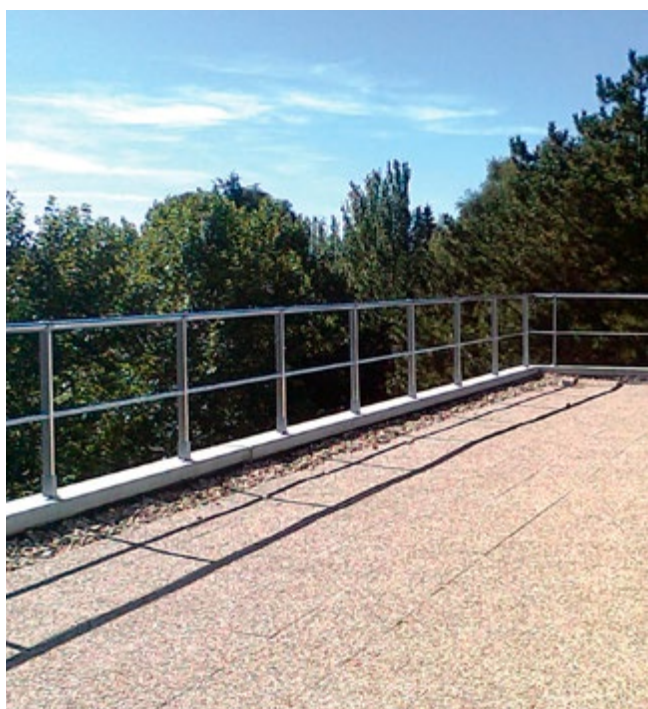
Parapetto dritto fissaggio in piano.
